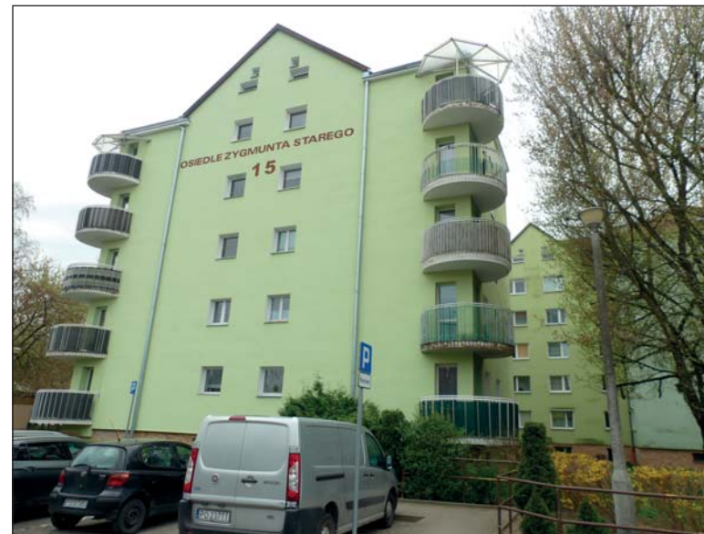
W budynku 15 na os. Zygmunta Starego wykonana została izolacja ściany fundamentowej
