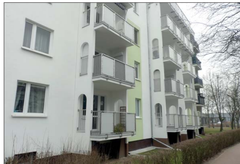
Odnowione balkony i elewacje budynku 38
