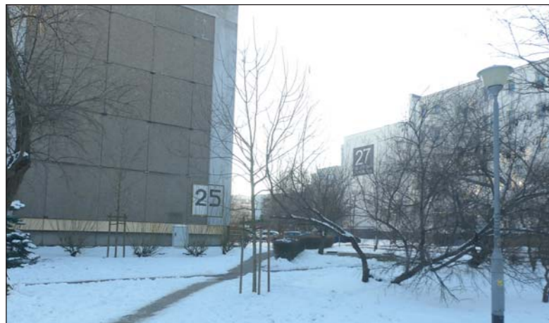
Wkrótce rozpocznie się termomodernizacja budynku 25
