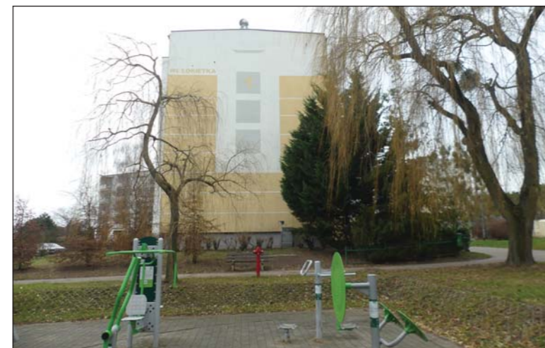
Wkrótce rozpocznie się odnawianie elewacji bloku nr 1
