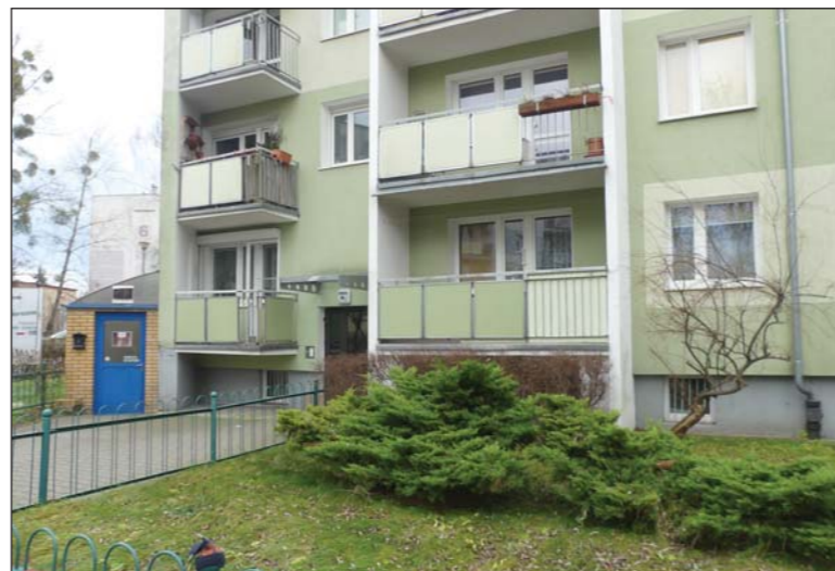
Osiedlowy klub przeprowadzi się do bloku 4I
