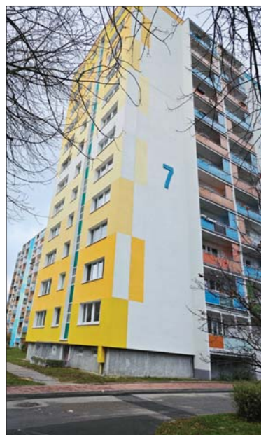
Odnowione elewacje budynku nr 7
