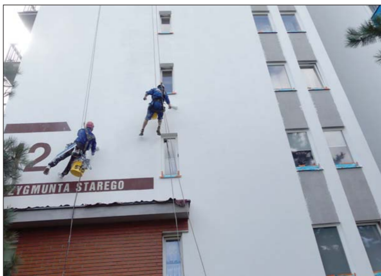
Malowanie ścian wysokich budynków wymaga alpinistycznych umiejętności
